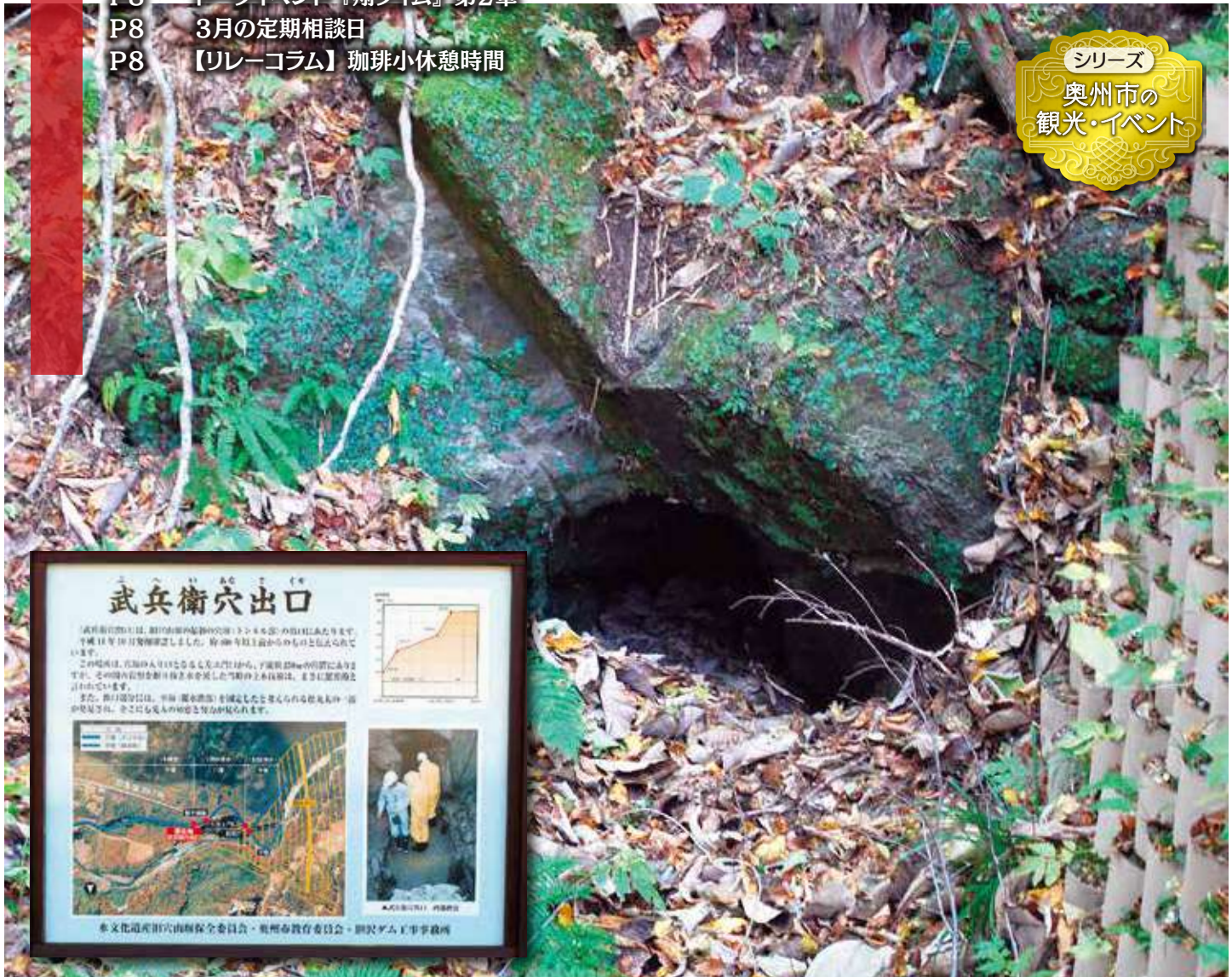
武兵衛穴出口 / 旧穴堰の最初の穴堰(トンネル部)の出口にあたります。約400年以上前のもので伝えられています。この場所は、穴堰の入り口となる七左エ門口から、下流約250mの位置にありますが、その間の岩盤を掘り抜き水を流した当時の土木技術は、まさに驚異的と言われています。
